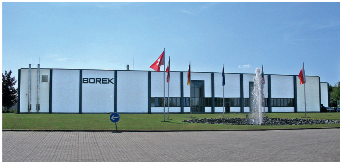
Firmengebäude von Borek media in Osterwieck
